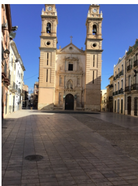
Imatge 3 Plaça Major de Canals
