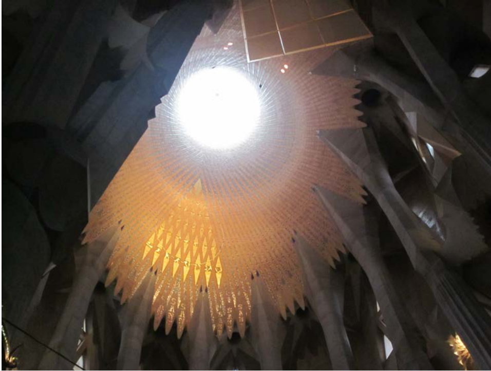
Sagrada Família, bóveda central con forma de hiperboloide de una hoja
