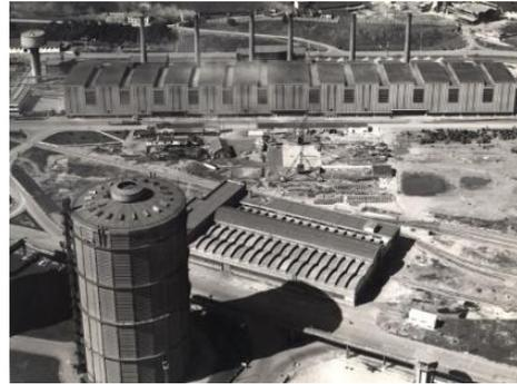
Los gasómetros de ENSIDESA en Avilés formaban una infraestructura esencial en el sistema de producción de la planta, permitiendo almacenar y regular el gas, *gas pobre*<sup>3</sup>, para los procesos de alto horno y cok. Tres gasómetros tipo M.A.N. fueron construidos en la planta de Avilés: el Avilés I, el Avilés II y el Avilés III.
